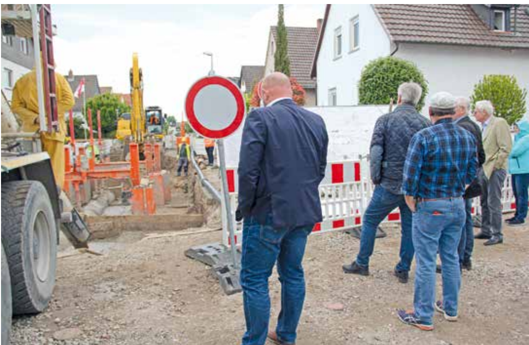
An der Baustelle Ostring, Ecke Schulstraße wird der Flüssigboden verfüllt. Das beobachten Bürgermeister Marcus Kretschmann, Baustellenleiter Ralf Purkl und die Stadträte Matthias Thurn, Wilhelm Wald, Christian Hofmann sowie Stadträtin Carola Friedrich. Foto: Stadt Riedstadt
