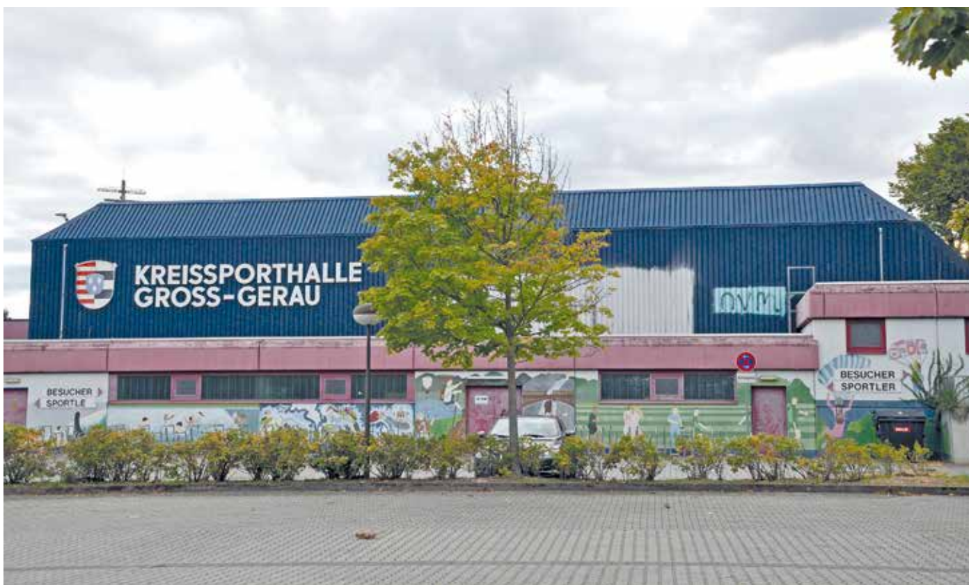
Ihr Gesicht wird die Kreissporthalle Groß-Gerau durch die anstehende Grundsanierung verändern.
