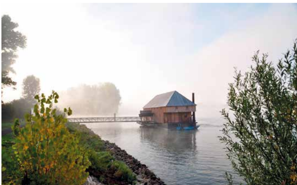
Immer einen Besuch wert: die Rheinschiffsmühle in Ginsheim. Sie kann an den „18. Tagen der Industriekultur“ besichtigt werden. Alle Termine und
