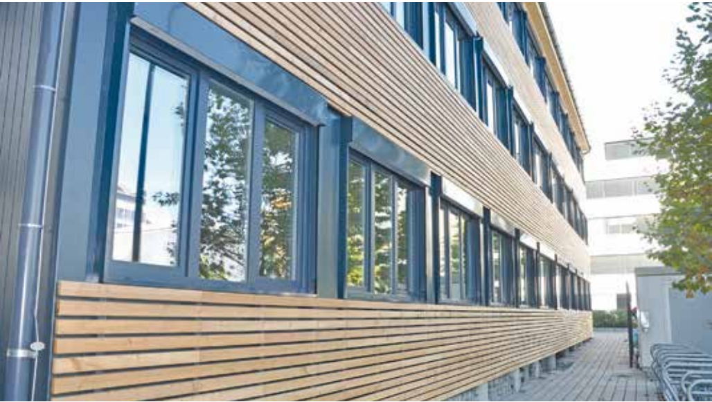
Die Containerbauweise ist auf den ersten Blick nicht zu erkennen: Das neue Bürogebäude am Landratsamt Groß-Gerau wird am Wochenende bezogen.
