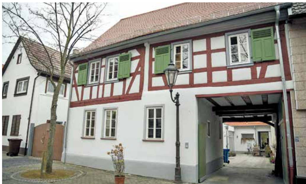
Außenansicht des sanierten Fachwerkhauses.
