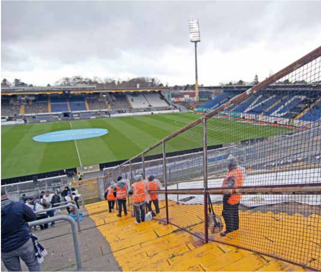
Umbau: In einem ersten Bauabschnitt wird die Gegengerade erneuert, dann gibt es auch eine neue Haupttribüne. Foto: Arthur Schönbein
