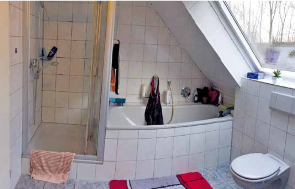
Badezimmer vor Renovierung: Eng und unpraktisch und bereits in die Jahre gekommen. Die Badewanne befindet sich direkt unter der Schräge, der hohe Sockel der Duschkabine erschwert den Einstieg. Foto: Kermi GmbH/akz-o
