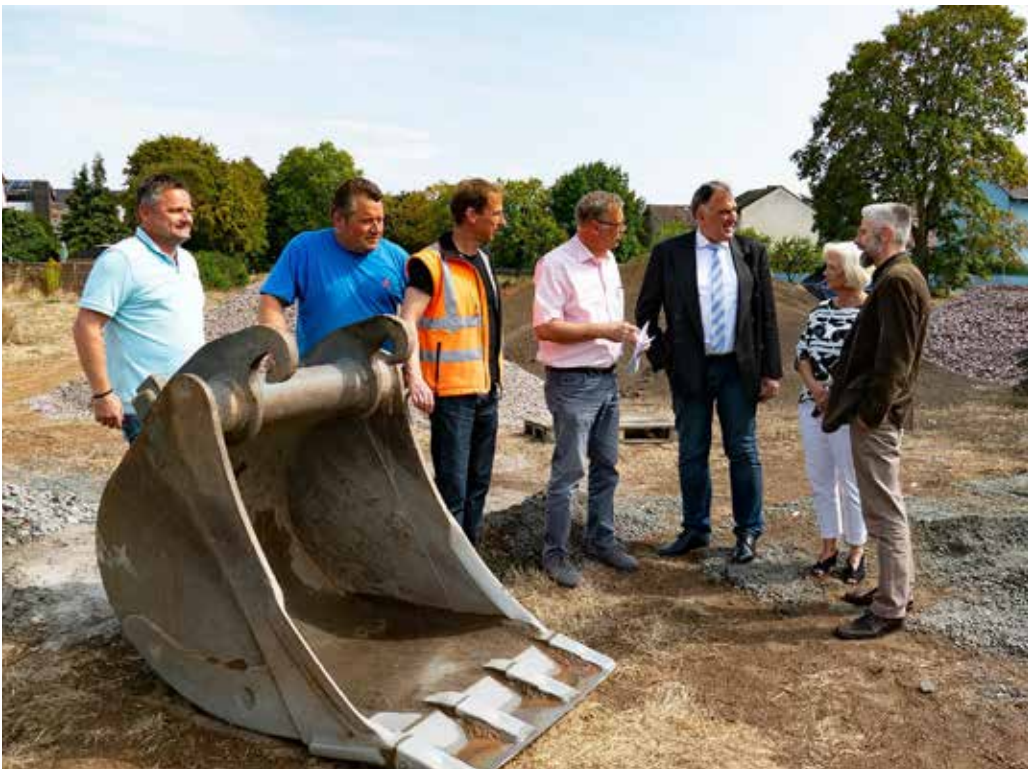
Zum Auftakt der Arbeiten im Worfelder Heißgraben kamen am 6. September 2018 (v.l.) Martin Speicher und Bernd Spangenberg (Knebel Baugesellschaft), Björn Sattler (IBE-Ingenieure), Werner Schäfer (Projektentwickler Terramag), Bürgermeister Andreas Rotzinger und Martina Lühder-Wagner und Bernd Lühder (Seniorenhausbetreiber) zusammen. Foto: Dieter Gölzenleuchter
