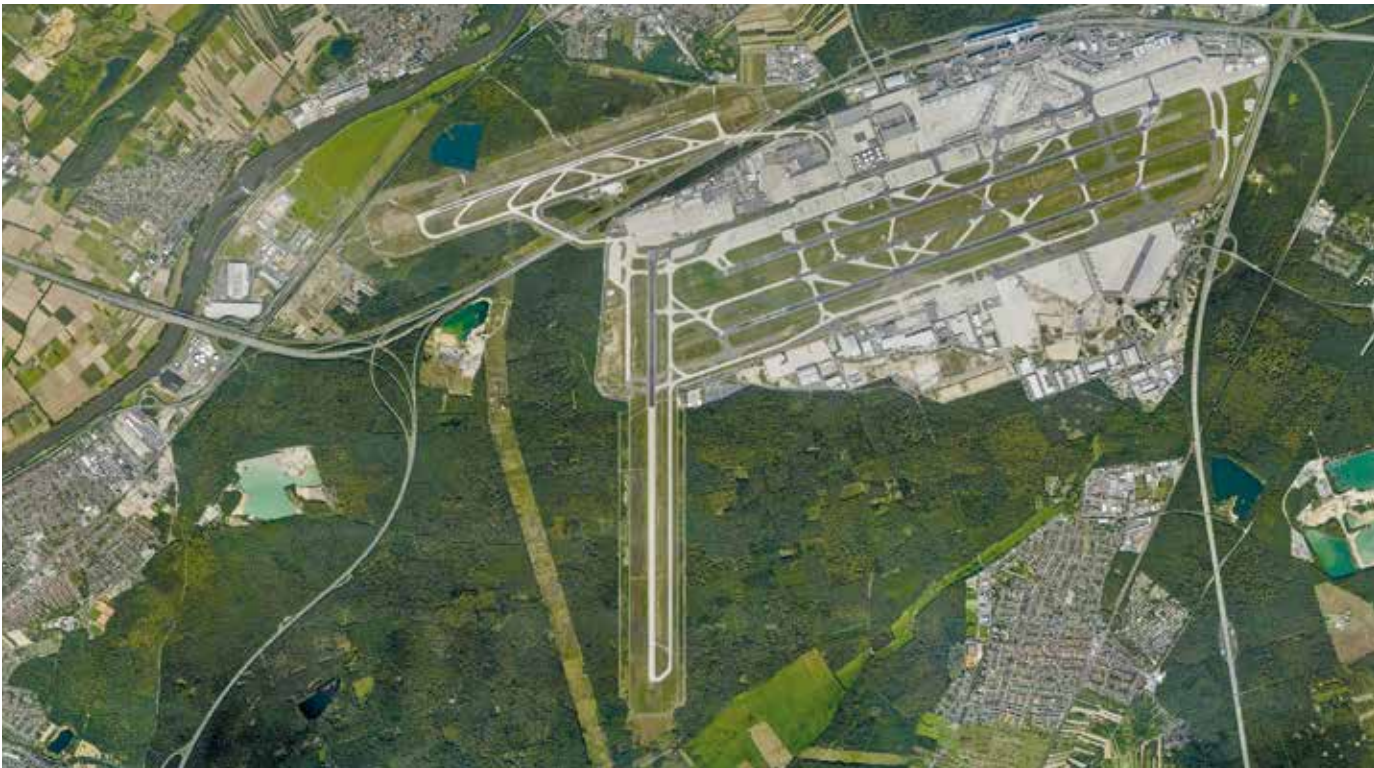
Auf der Luftaufnahme ist am Flughafen unten rechts im Bild entsteht das neue Terminal mit Flugsteig G.
