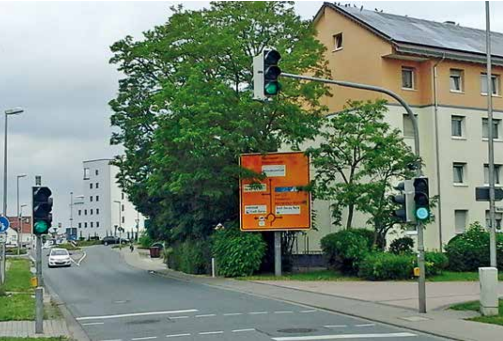
Technisch aufgerüstet ist seit Ende Mai die Fußgängerschutzanlage im Kreuzungsbereich von Breslauer Straße und Reichenberger Straße. LED-Signalgeber sorgen nun dafür, dass auch bei ungünstigen Lichtver- hältnissen – beispielsweise tiefstehender Sonne – eindeutig erkennbar ist, welches Signal gerade leuchtet. Darüber hinaus ist eine Videokamera installiert worden, die Fußgänger, die die Breslauer Straße queren, erfasst und bei Bedarf das Signal „Grün“ für Fußgänger verlängert. Text/Foto: Stadt Groß-Gerau
