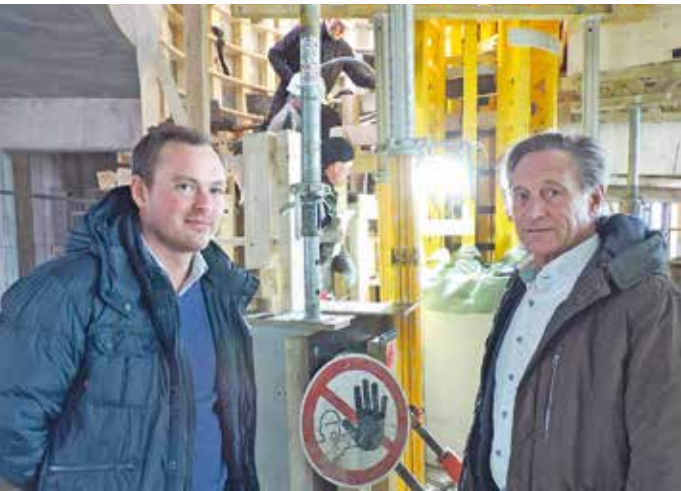
Kiesel-Projektleiter Björn Hickmann (links) und der Erste Kreisbeigeordnete Walter Astheimer inspizieren das Bauprojekt „Technik-Welt“.
