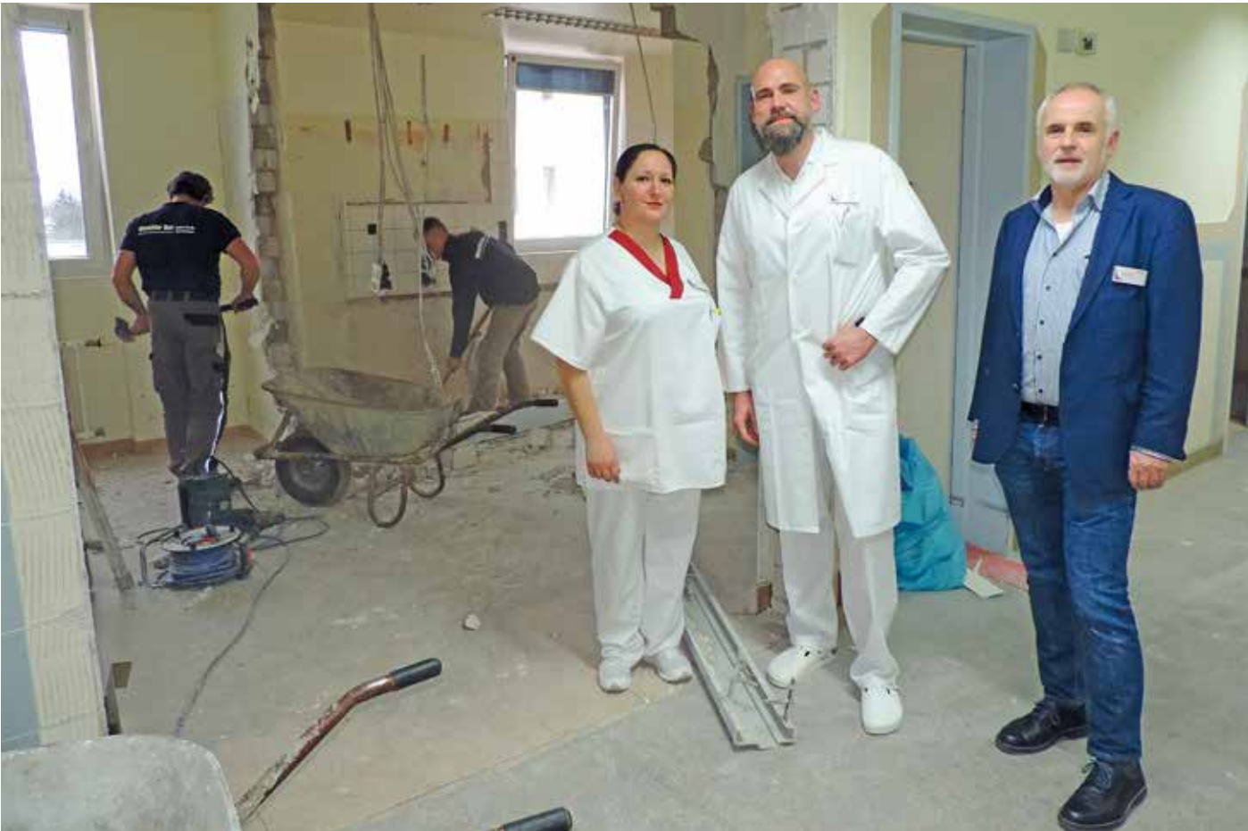
Zu Beginn der Arbeiten für die allgemeinchirurgische Station in der Groß-Gerauer Kreisklinik schauten sich Klinik-Geschäftsführer Reinhold Linn, Chefarzt Thomas Schumann und die künftige Stationsleiterin Fadma Chamkha die Baustelle an.
